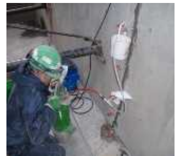
ひび割れ注入状況
