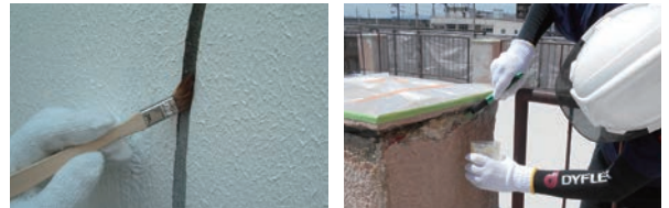
ひび割れ充填のプライマー用途
