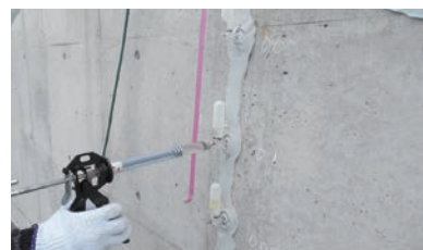
6. エポキシ樹脂注入
