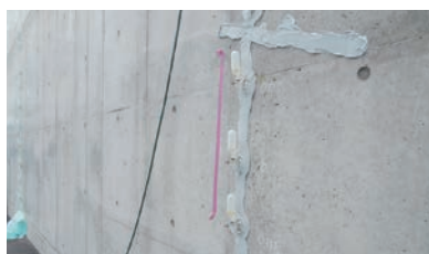
7. エポキシ樹脂の硬化養生
