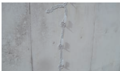
5. 仮止めシール材の硬化養生
