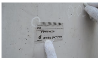
1. 事前確認・ひび割れ調査
