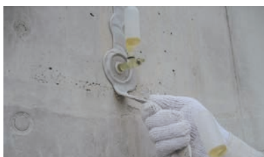
8. プラグと仮止めシール材の撤去
