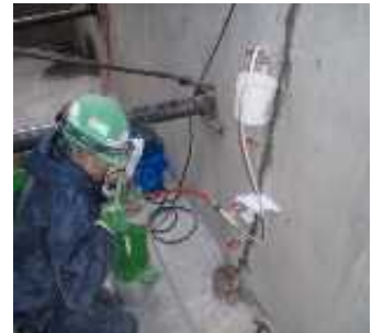
ひび割れ注入状況
