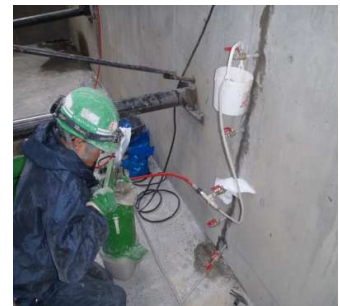
ひび割れ注入状況
