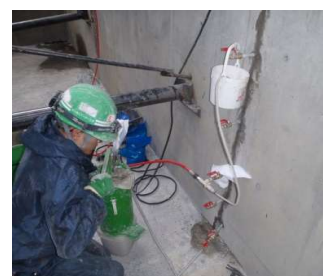
ひび割れ注入状況
