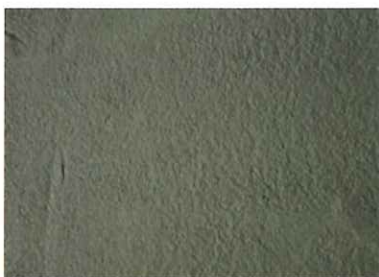
⑧ シートによる封緘養生
