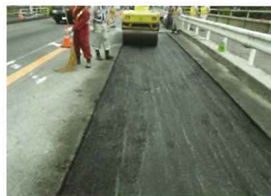
⑨ 橋面防水及び舗装復旧
