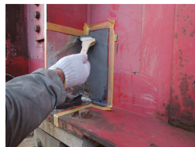
■プライマー塗布
