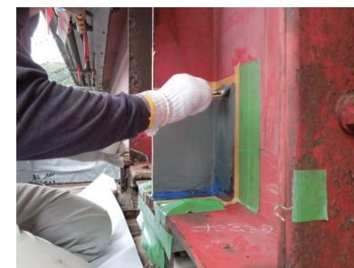
■高伸度弾性パテ材用プライマー塗布
