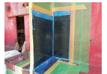
■炭素繊維シート貼付け
