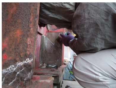
■錆び、旧塗膜の除去
