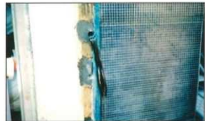
CFアンカーの挿入
