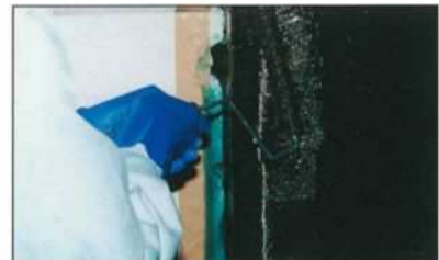
CFアンカーの貼付け
