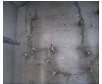
ひび割れシール・プラグ取付
