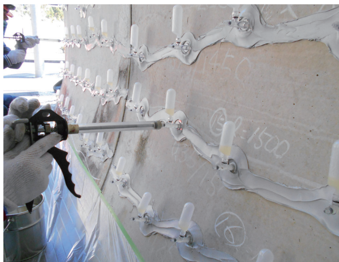
土木構造物 改修 トンネル内壁
