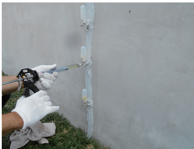
建築構造物 新設 腰壁
