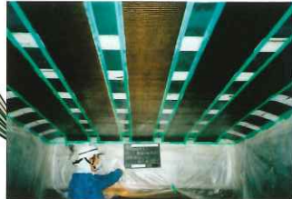
床版への施工例
