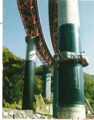
橋脚への施工例
