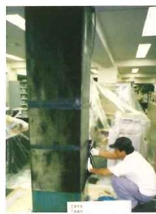
独立柱への施工例
