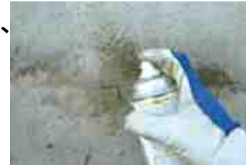
欠陥部へのインフィルゾル吹付
