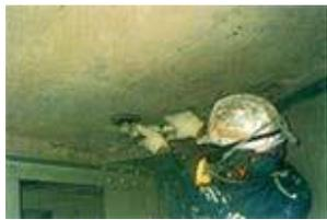
コンクリート表面の劣化層の研磨・除去、ひび割れ補修等を行う。
