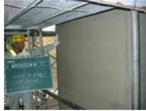
日本道路公団 炭素繊維巻立て工法の仕上材B工 規格適合品
