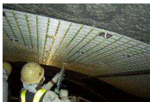
トンネル覆工部への施工
