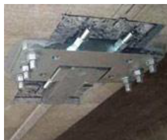
アウトプレート緊張装置
