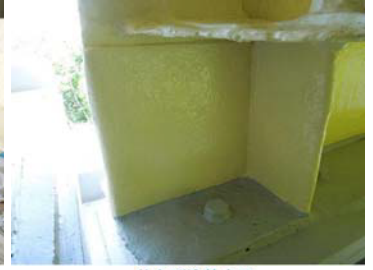
仕上げ塗装完了
