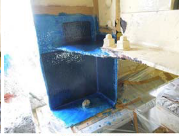
炭素繊維シート接着
