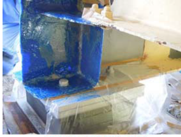
不隙修正（孔食部パテ埋め）
