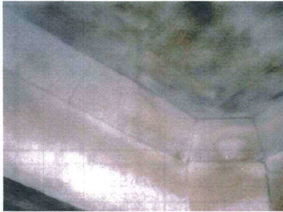
写真1 試験塗装部11年経過時外観
