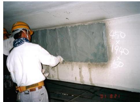
①主筋と下地の間に確実に充填するように 1 層目を塗布する。
