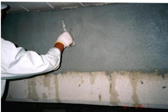
⑤仕上げ表面のしまりを確認後※、リフレトリートを 60g/m<sup>2</sup>を目安に仕上げ表面に噴霧し、鏝で押さえ込む
