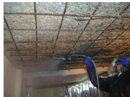
ウォータープラストを用いた鉄筋ケレン状況
