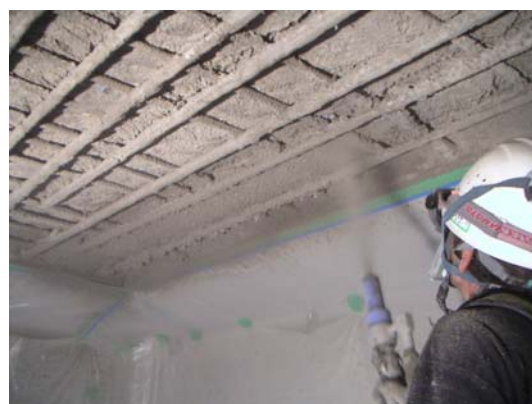
鉄筋裏充填状況
