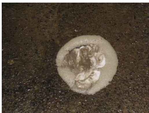
写真 確認孔からオーバーフローして充填完了したフィルコンライト All in One
