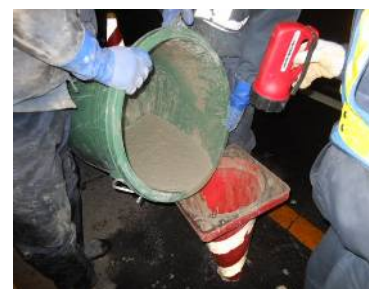
自重圧による注入例
