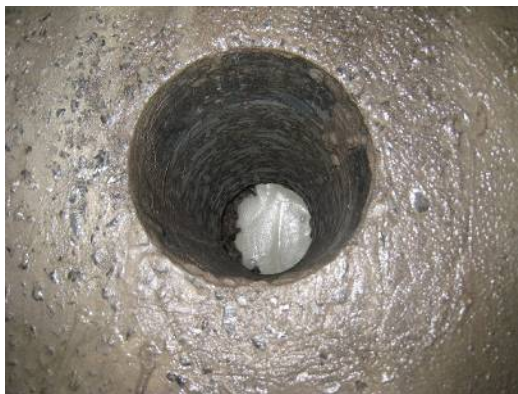
写真 確認孔の下を流動して通過するフィルコンライト All in One
