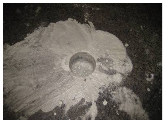
写真 確認孔からオーバーフローして充填完了したフィルコンライト All in One
