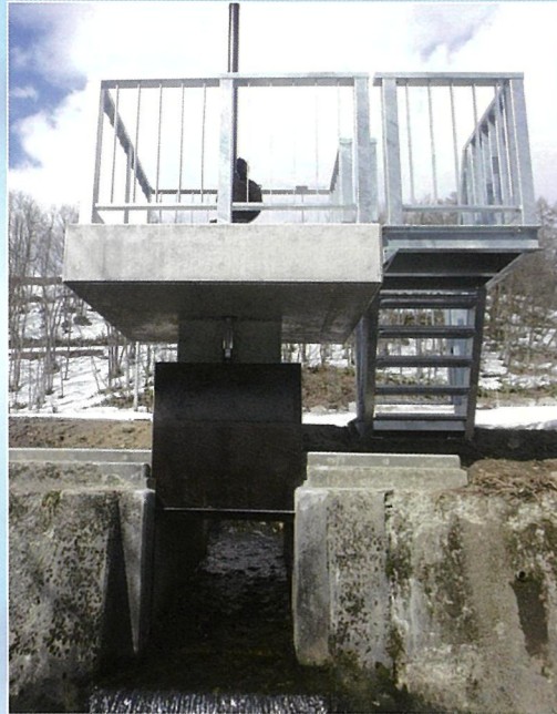
銚川村 ギアラック式スルースゲート
