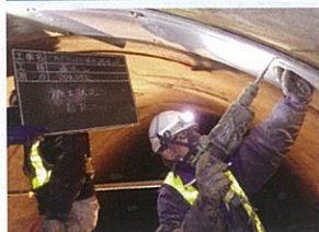
アンカー孔削孔
