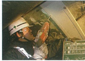
アンカー孔削孔
