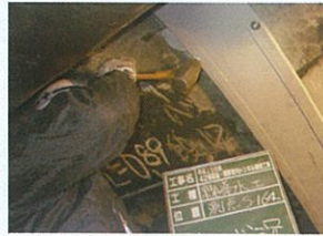
アンカー打設
