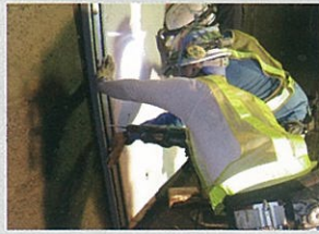
アンカー孔削孔
