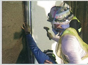
アンカー打設
