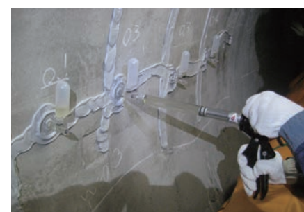
地下ビットひび割れ注入
