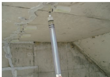
コンクリート打放し・上裏面
