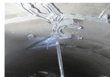
トンネル内壁ひび割れ注入
