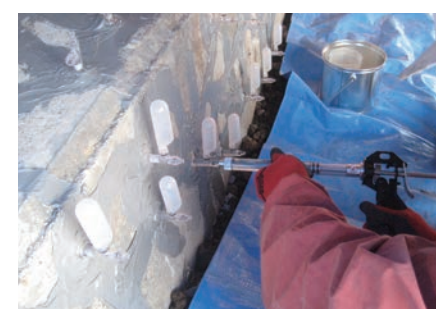
橋台ひび割れ注入
