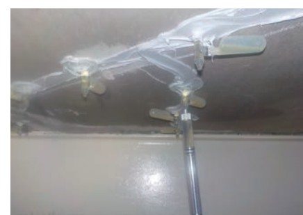
床版ひび割れ注入
