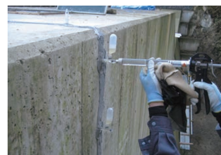
砂防堰堤ひび割れ注入
