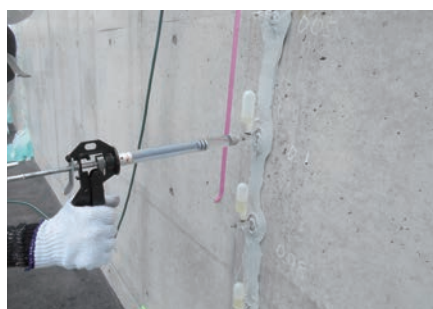
コンクリート打放し面
