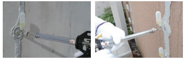
ひび割れ注入
