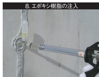
8. エポキシ樹脂の注入 DF ポンプ - 4 & 5 で注入を行う。
