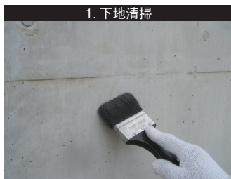
1. 下地清掃 ひび割れ付近をダスター刷毛等で清掃する。
