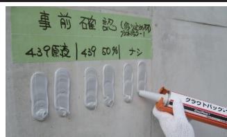
仮止めシールのテスト施工
