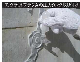
7. グラウトプラグ A の圧力タンク取り付け 床面・上げ表面は、圧力タンクの取り付けの向きに注意する。
