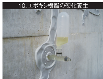
10. エポキシ樹脂の硬化養生 圧力タンクに樹脂が溜まった状態で硬化させる。
