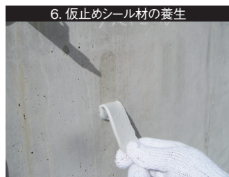
6. 仮止めシール材の養生 硬化確認用のテストシールで硬化を確認する。
