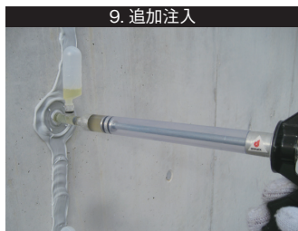
9. 追加注入 圧力タンクに樹脂が無くなれば粘度を高めて追加注入する。
