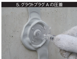
5. グラウトプラグ A の圧着 プラグ A の取り付け座を圧着する。 (必要に応じてプラグ A の付属の透明ホースを活用する。)
