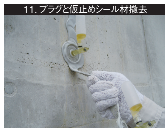
11. プラグと仮止めシール材撤去 最初にドライバー等でプラグを撤去した後、仮止めシールを撤去する。
