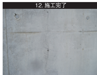
12. 施工完了 注入後にアクアストップ等の浸透性吸水防止材等を塗布する際はグラウトパック®-439 を塗布した箇所を水洗いで洗い流して施工して下さい。
