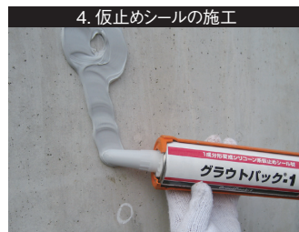
4. 仮止めシールの施工 グラウトパック®-1 でひび割れシールを行うと同時にプラグ取り付けシールを行う。
