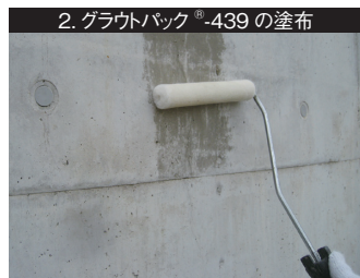
2. グラウトパック®-439 の塗布 100mm程度のローラー刷毛等でひび割れに沿って塗布する。
