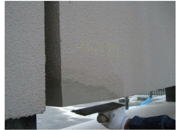
充填材の充填・仕上げ
