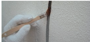
5. プライマー塗布
