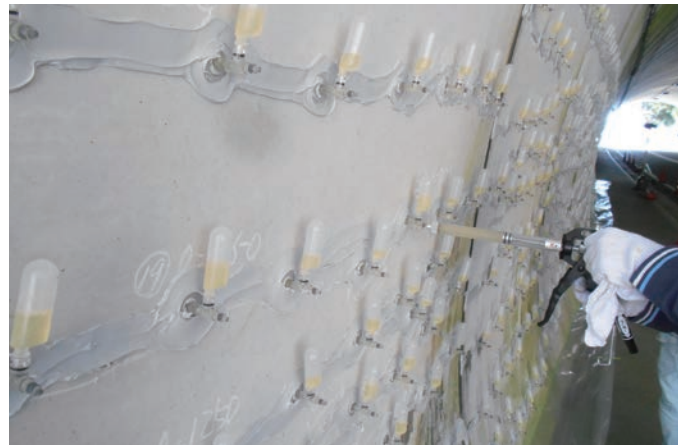
土木構造物 改修 トンネル内壁
