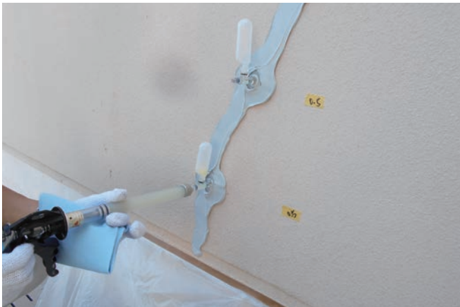
建築構造物 改修 外壁塗装面
