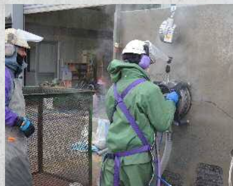
ツイスター30による壁面処理
