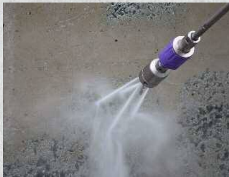
ロータリーノズルによる表面処理
