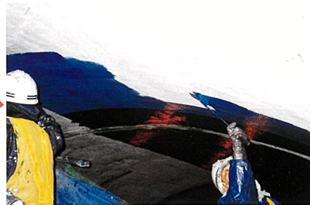
プライマー塗布
