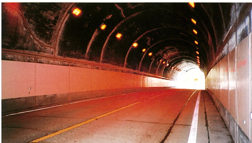
◀横打継目地・連続施工
