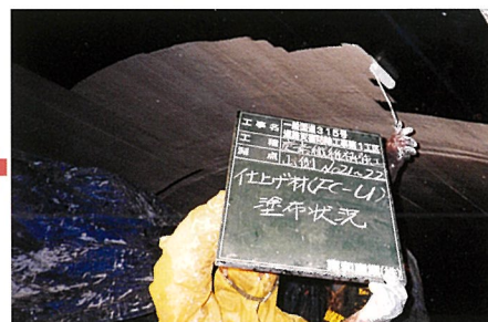
仕上げ材塗布
