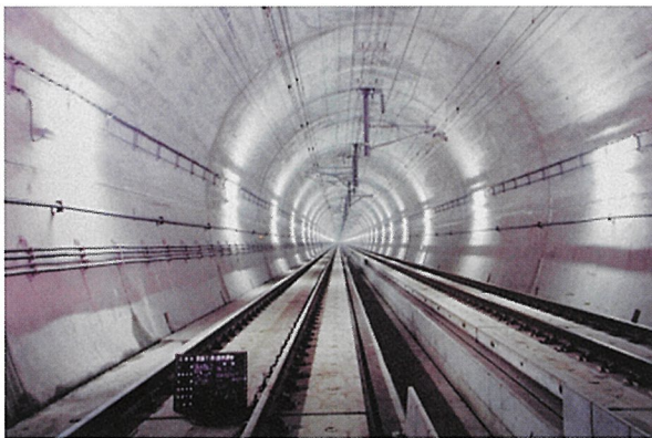
青函トンネルの建設時
