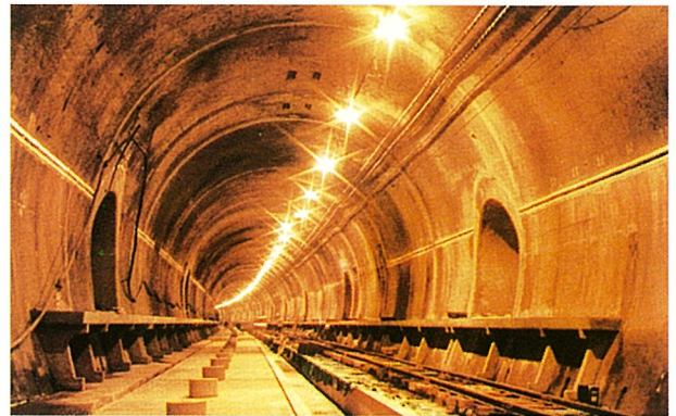
▲本坑内完成区間（プラットフォーム）
