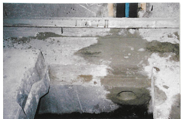
漏水対策：端末処理
