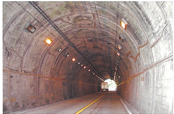
一般国道の漏水対策
