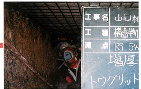
補強材取付け
