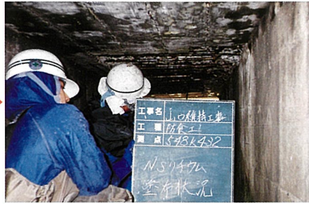
浸透性防錆剤塗布
