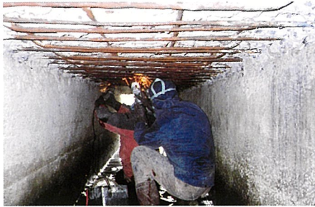
腐食鉄筋ケレン
