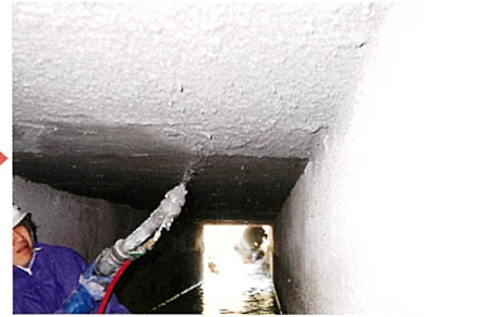
断面修復材吹付け
