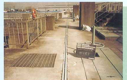
▲下水処理場目地施工後
