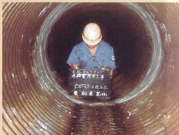
▲コルゲート管ジョイント補修 (T-6)
