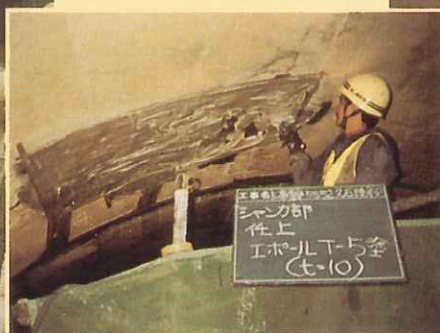
▲施工中(エポールT-5)
