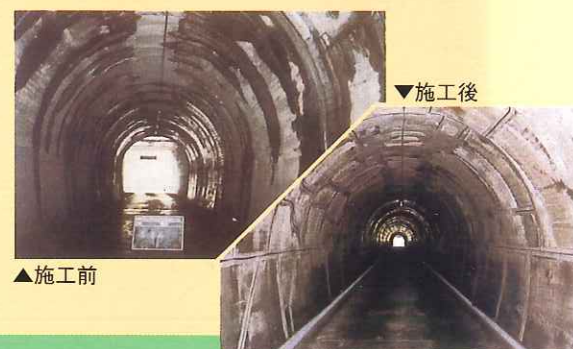
▲トンネル補強充填
