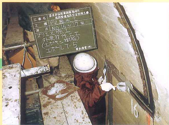
▲トンネル補強充填
