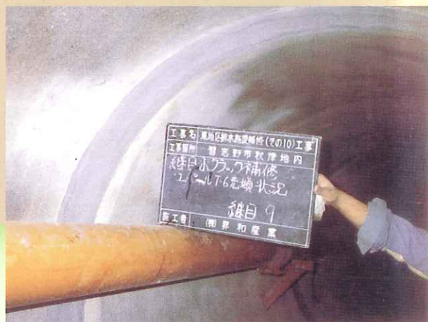
▲ヒューム管ジョイントの充填 (T-6)
