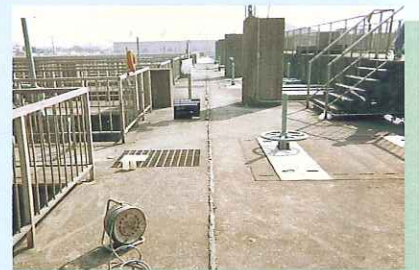
▲下水処理場目地施工前
