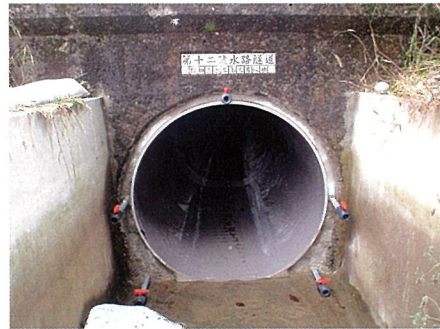
⑤インパイプ中込工
