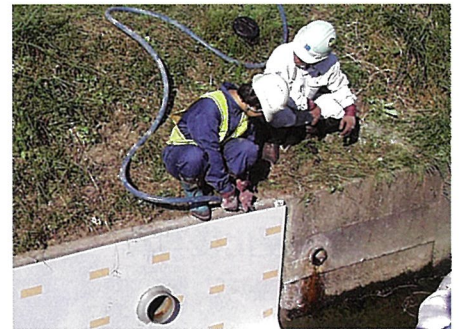
⑥水路補修中込工
