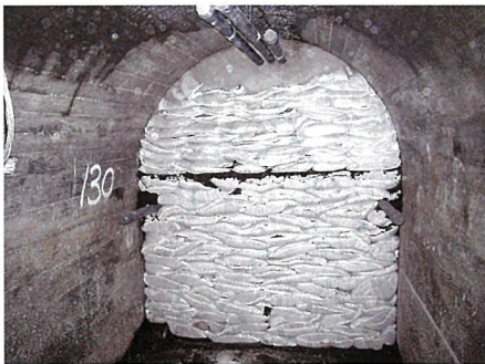
②残置隧道閉塞工
