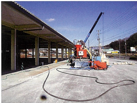
③床下充填工
