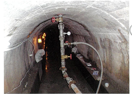
⑦トンネル裏込工
