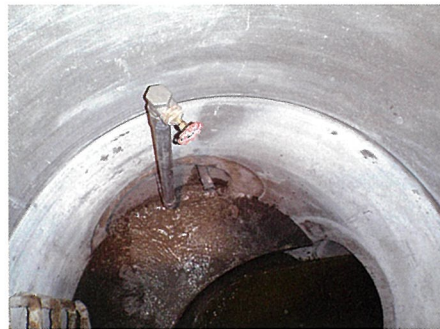
④残置管閉塞工
