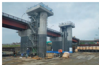
頭首工堰柱表面保護
