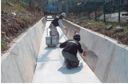
3. プライマー塗布
