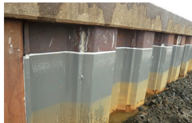
鋼矢板排水路
