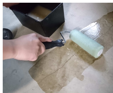
ローラー、ハケによる施工
