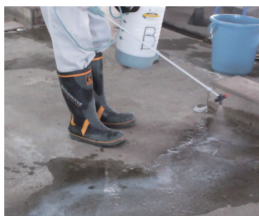
噴霧器による施工
