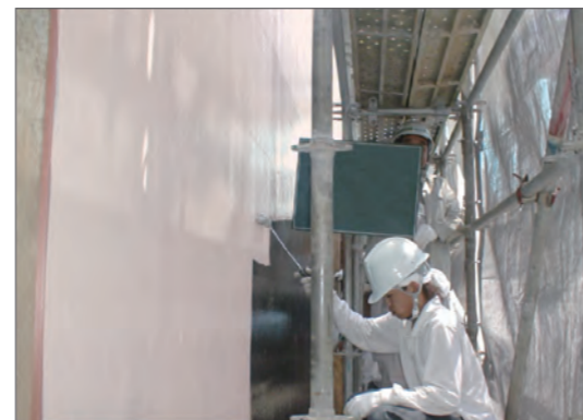
プライマー施工状況
