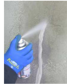
欠陥部へのインフィル・ゾルス吹付
