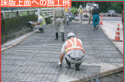
床版上面への施工例
