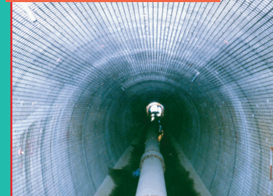
水路トンネルへの施工例
