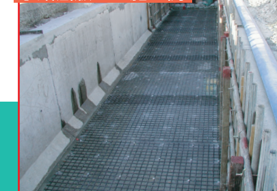
水路底版への施工例
