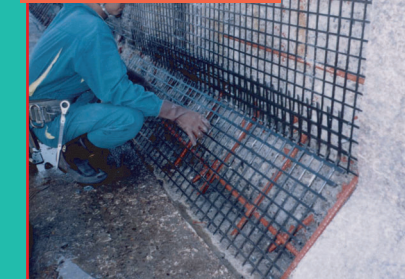
水路側壁への施工例
