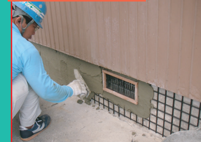
住宅基礎への施工例
