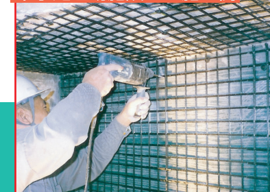
下水処理場施設への施工例
