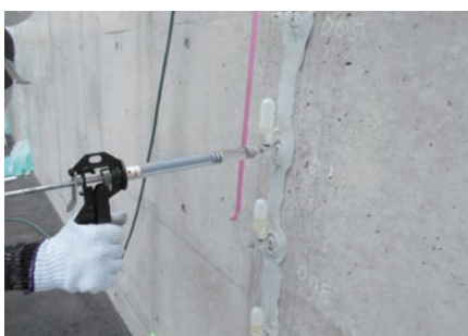
コンクリート打放し面
