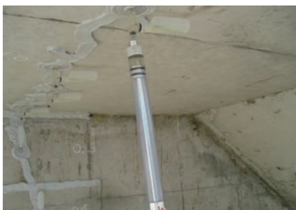
コンクリート打放し・上裏面
