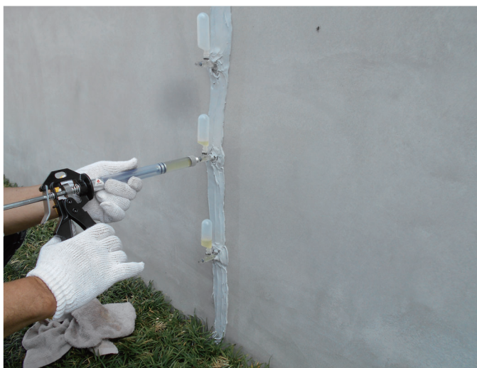
建築構造物 新設 腰壁
