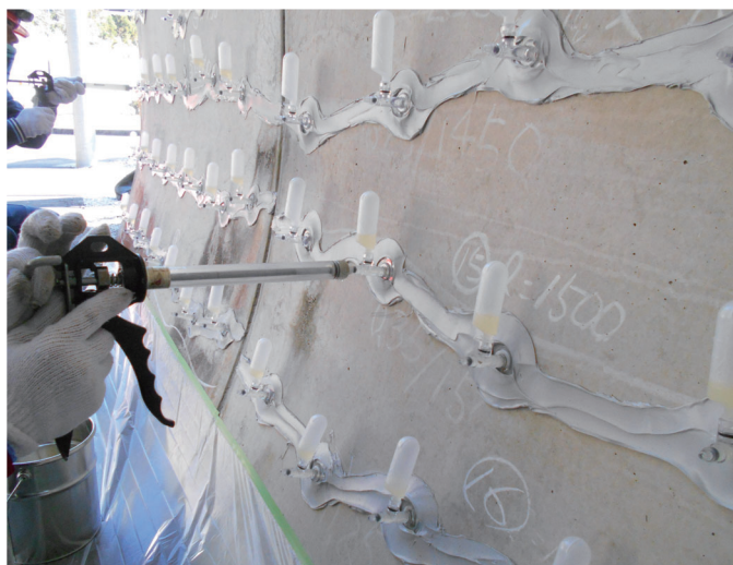
土木構造物 改修 トンネル内壁
