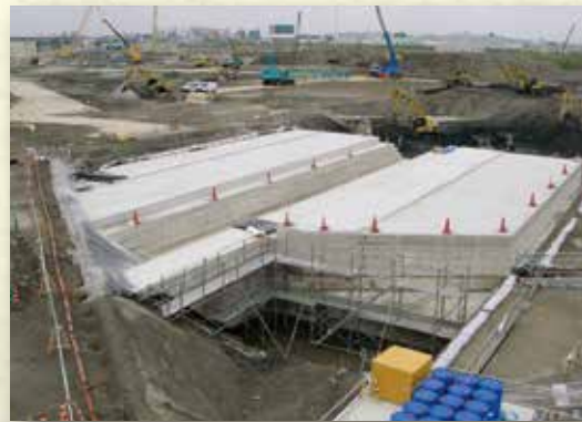
●置換盛土(地下構造物荷重軽減)
