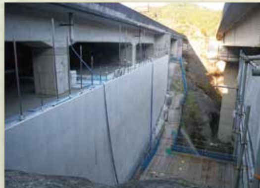
●橋梁耐震補強(桁下空間への充填)
