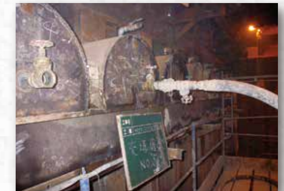
● パイプルーフ中詰工
