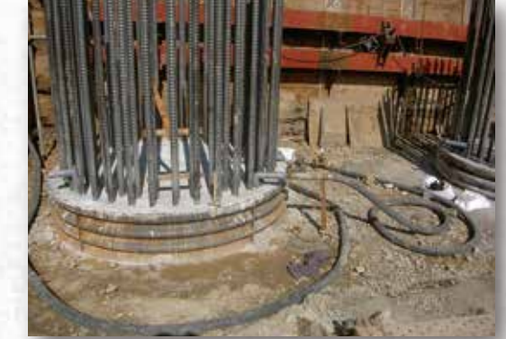
● 深礎杭裏注入
