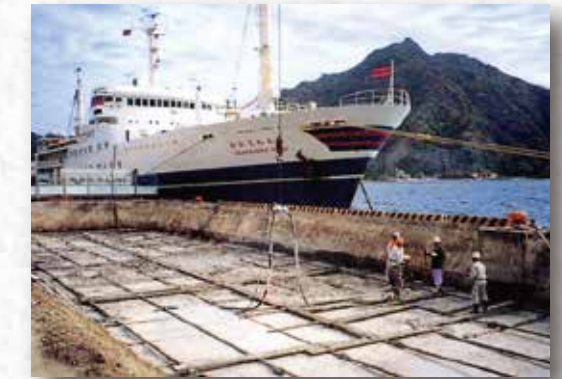
● 護岸工事の採用例(置換盛土)
