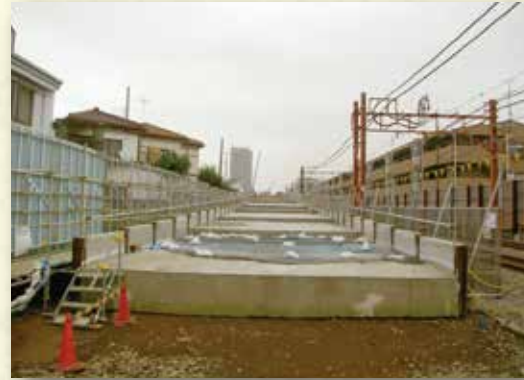
●軌道(鉄道)下路床(気泡モルタル盛土)
